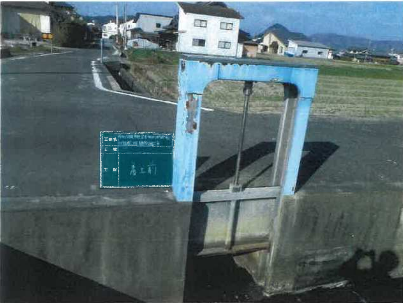
スライドゲート 着工前
