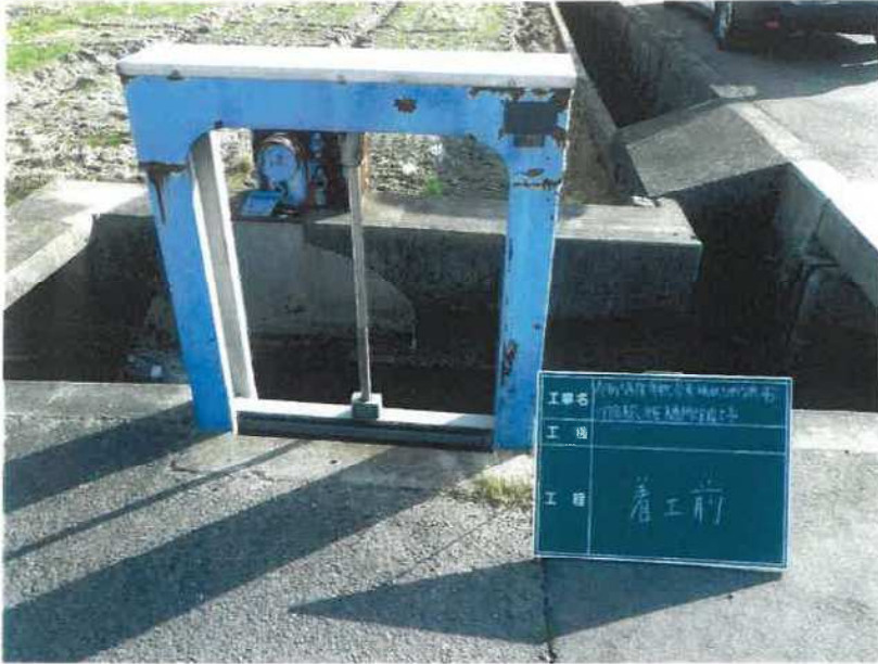
スライドゲート 着工前
