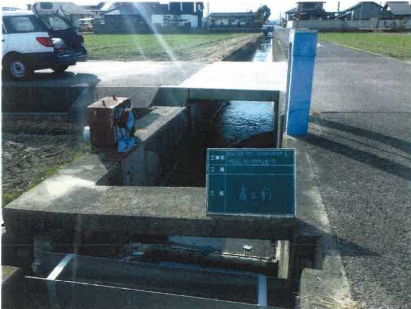
転倒堰 着工前
