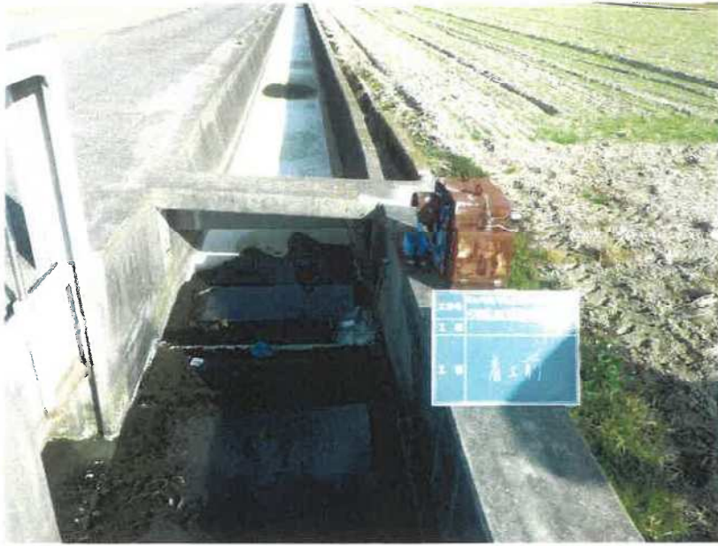
転倒堰 着工前
