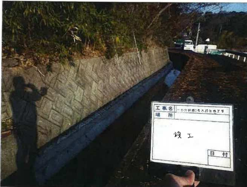
水路工事 着工前・竣工 竣工
