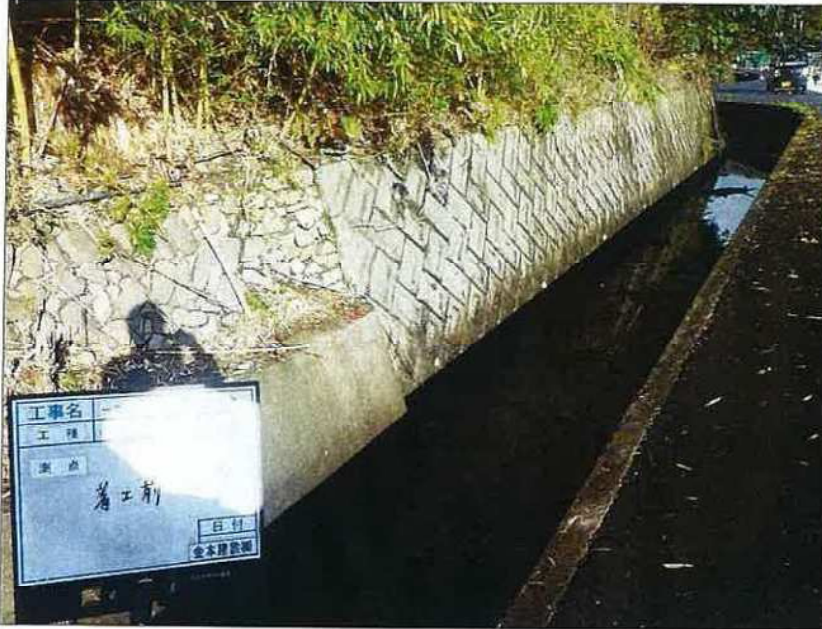
水路工事 着工前・竣工 着工前
