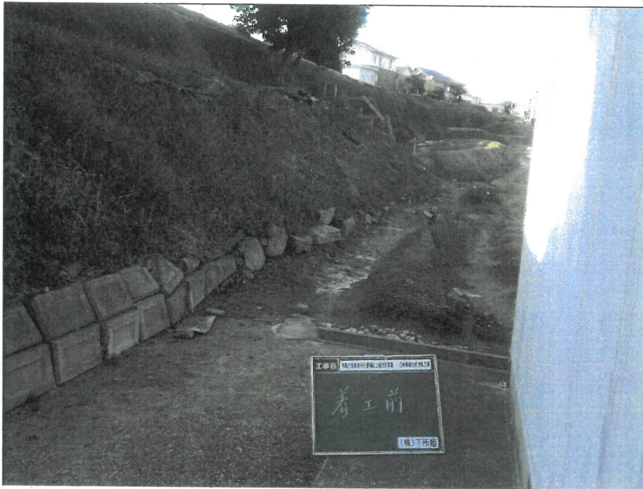
着手前及び完成写真 着工前
