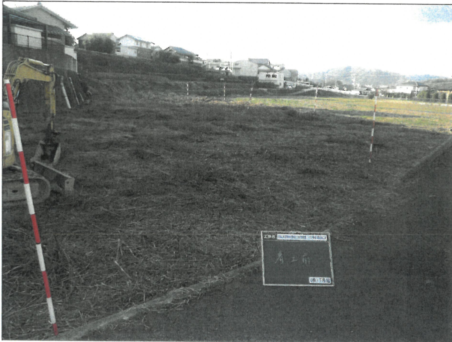
着手前及び完成写真 着工前
