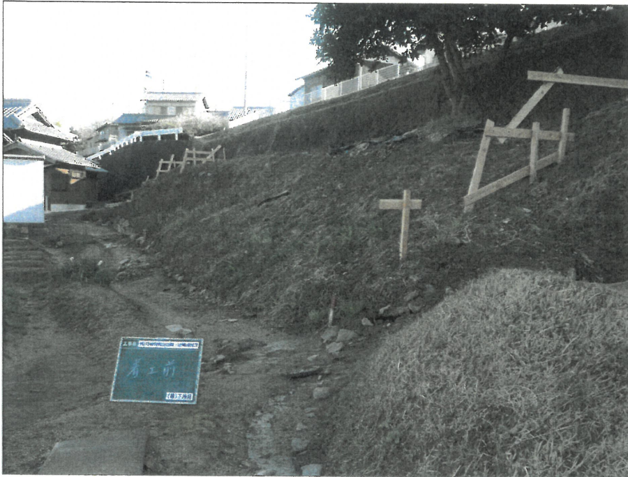
着手前及び完成写真 着工前
