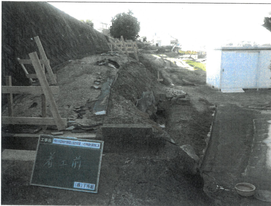
着手前及び完成写真 着手前
